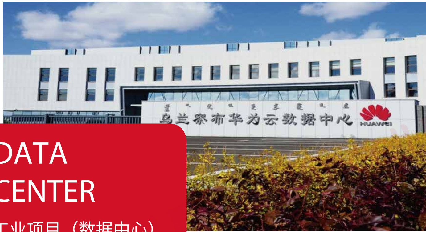
华为数据中心（内蒙古、乌兰察布、贵阳.....）
