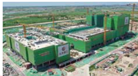
北京二一工程主体建筑项目
